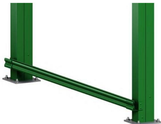
Смонтированный первый нижний прогон
